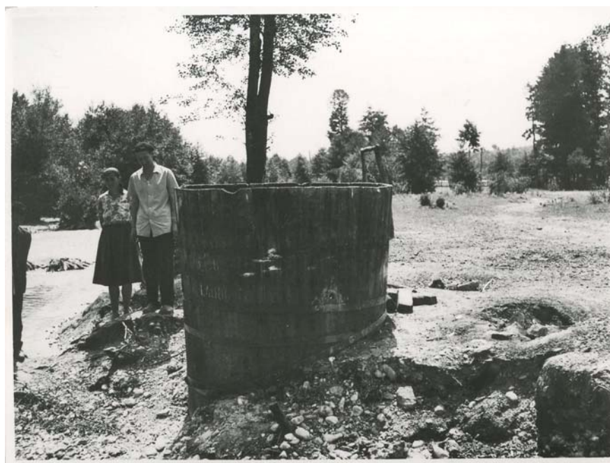
Sârbești, județul Gorj, pe Olteț la bateria de răcire a instalației alambicului (Arhiva foto a Muzeului ASTRA)
