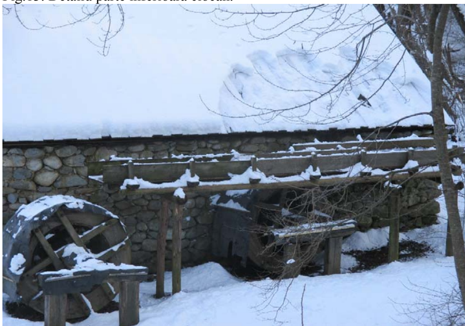
Fig 14. Clădirea de adopostire a instalației uleiului din Ohaba-Sibișel și roțile hidraulice care acționează ciocanele pivei și teascul. Fotografie din Muzeul în aer liber Sibiu
