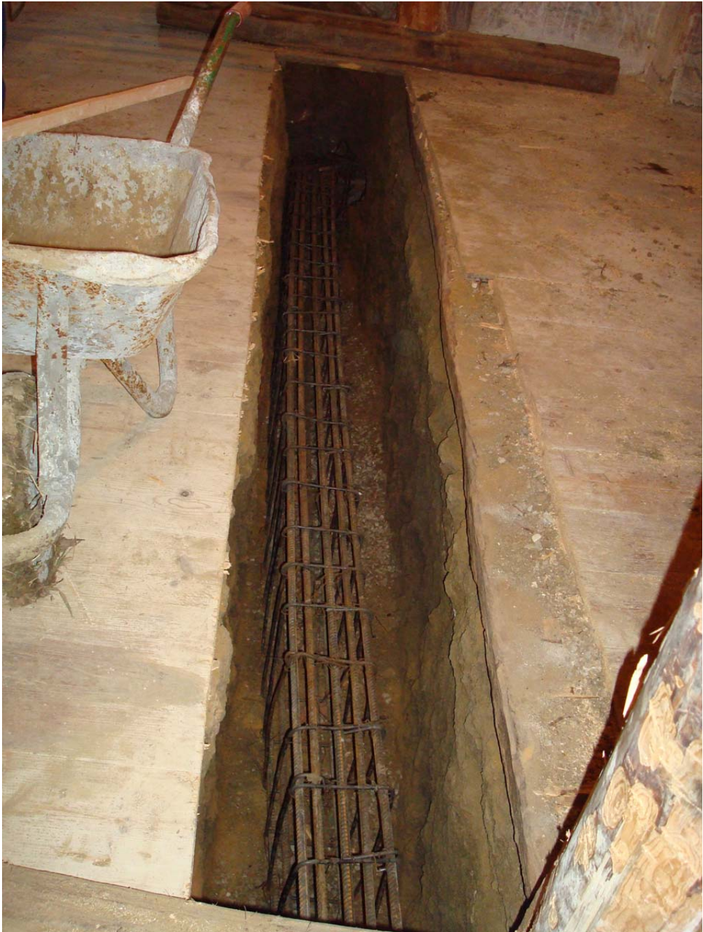
Pl. IV: Mănăstirea Strâmba-Jiu Aspect de săpătură
