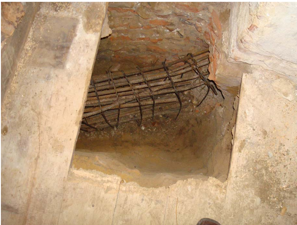
Pl. V: Mănăstirea Strâmba-Jiu Aspect de săpătură
