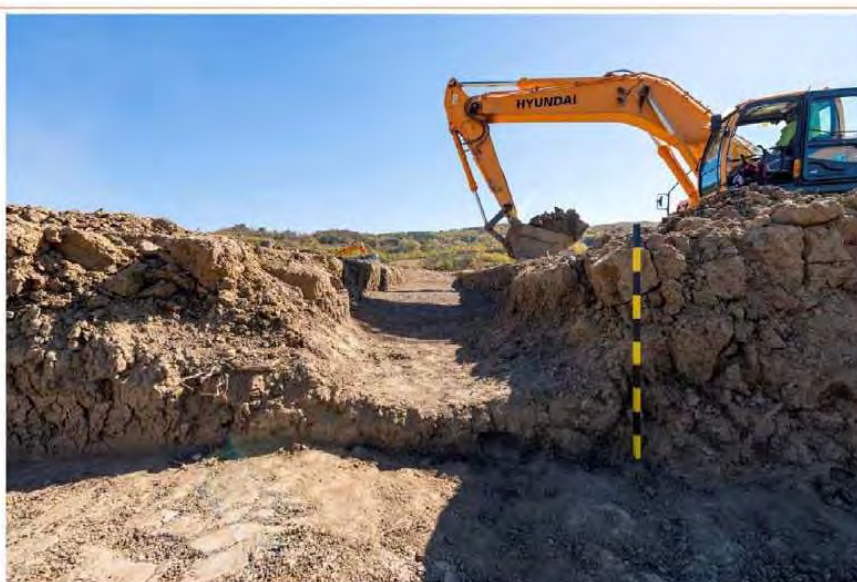
Foto 26. Relația pe verticală dintre zona cercetată și o secțiune martor a diagnosticului intruziv.
